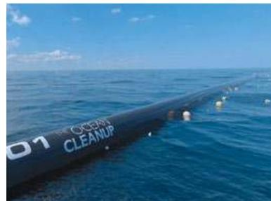
È stato inaugurato il primo Ocean Cleanup System in California: un serpente di gomma ancorato al fondale, lungo 609 metri, in grado di trattenere, lungo tutta la sua lunghezza, i rifiuti galleggianti, soprattutto plastica e di consentirne una più facile raccolta. La struttura è dotata di sistemi anticollisione, videocamere e antenne in grado di informare le imbarcazioni della sua presenza.
